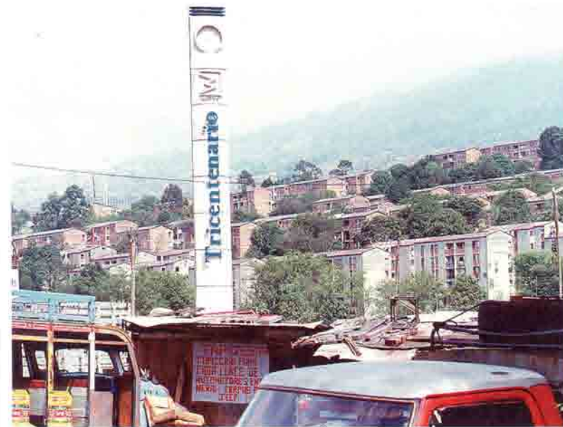
Foto N° 6. Vista del barrio Tricentenario desde la estación del Metro
